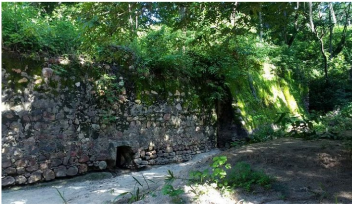
Imagem 5 - Barragem/Paredão de Pedra
