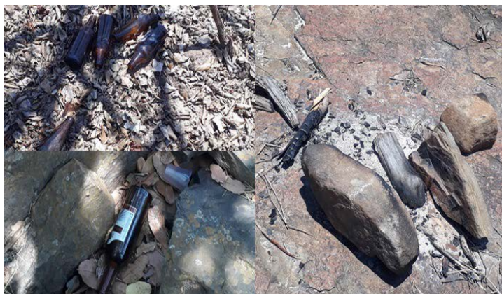
Figura 40 - Deterioração provocada por ação antrópica/Cachoeira das Corujas
