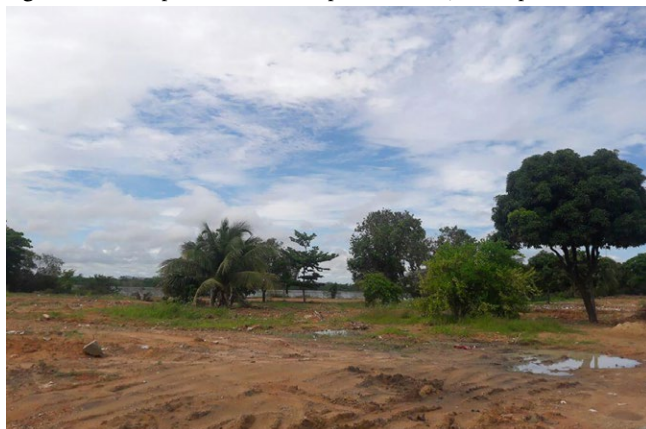
Figura 1 – Vista parcial do Beiral após a demolição das primeiras casas
