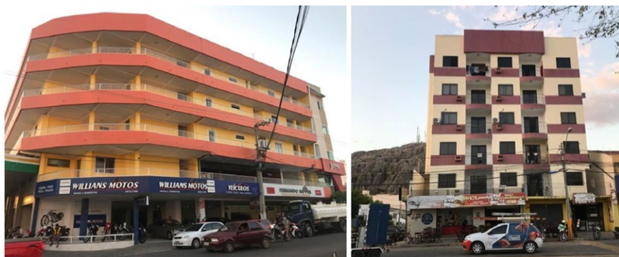
Figura 3: Imóveis verticalizados para locação e ocupados, principalmente, por estudantes em Quixadá.
