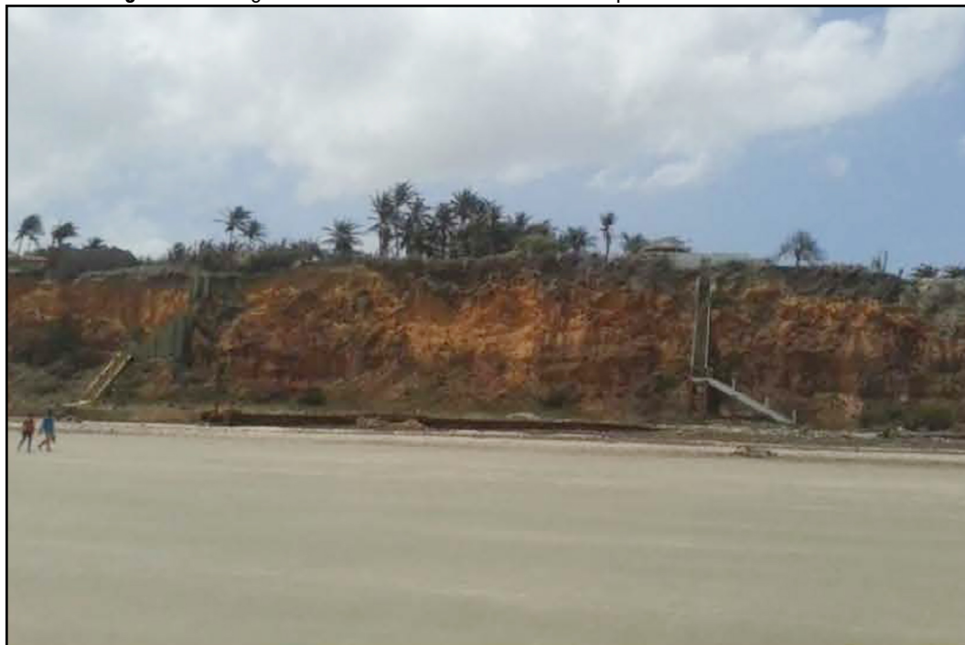
Figura 6 – Fotografia mostrando as escadarias de uso particular na face da falésia
