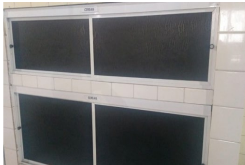
Figura 16 - porta com revestimento adequado
