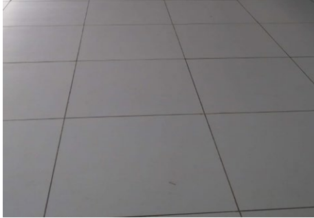
Figura 15 - Piso com revestimento adequado
